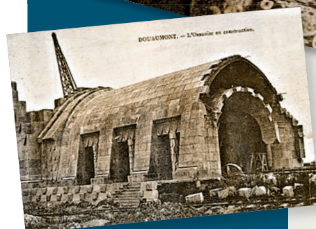
Douaumont, l'ossuaire en construction
