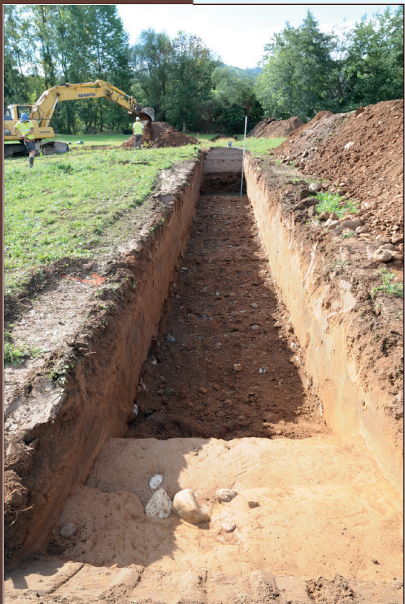
Vue de la tranchée 2
